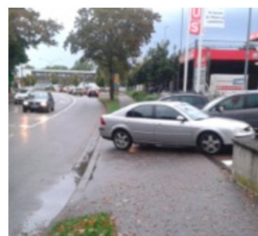
Abb.: 14 – Zufahrt Bauhaus West
