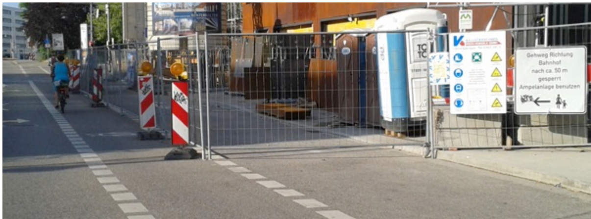
Abb.: 19 – Gefährliches Fußweg-Ende
